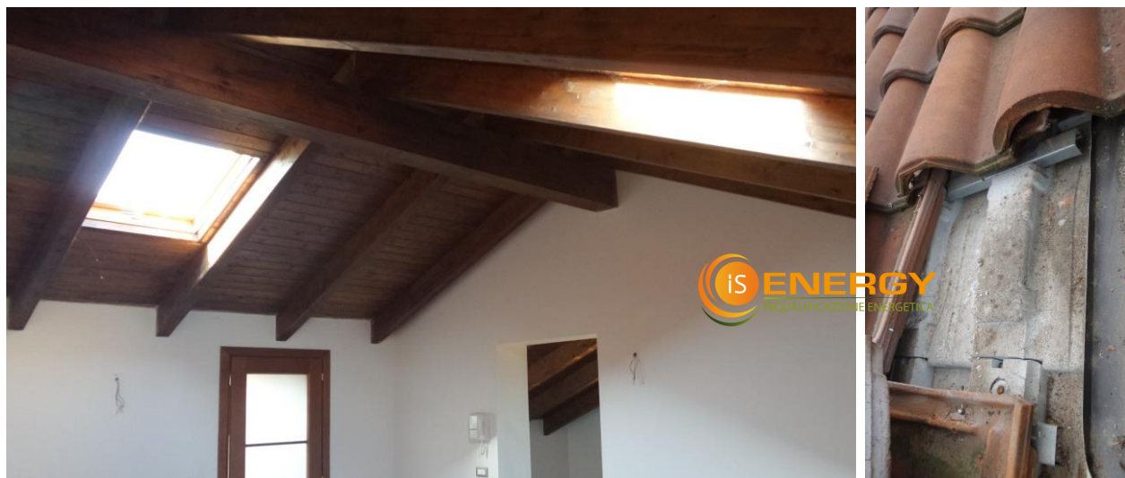
Tetto in legno: perlinato con pannelli da 6 cm di polistirene sottotegola. Il tetto risulta poco coibentato, soprattutto per evitare il surriscaldamento estivo.
