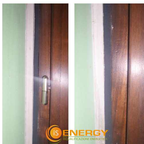
INFISSI: rimontaggio con nastro poliuretano autoespandente per la tenuta all'aria
