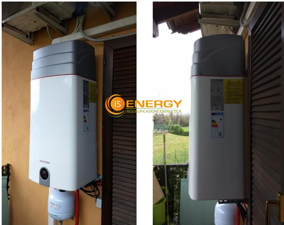
**ACQUA CALDA SANITARIA:** una pompa di calore KRONOTERM WP1 da 100 litri garantisce acqua calda sanitaria assorbendo solo 220W di energia elettrica.
