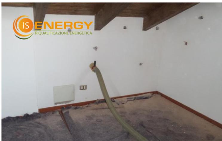
**Insufflaggio:** coclea con extra-soffiante per lana di vetro **KNAUF SUPAFIL**
