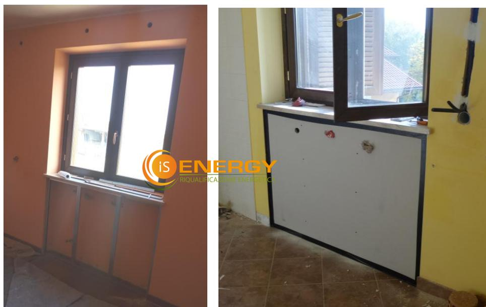
**SOTTOFINESTRA:** eliminazione radiatore e posa doppia lastra da 15mm con insufflaggio lana di vetro **KNAUF SUPAFIL**.
