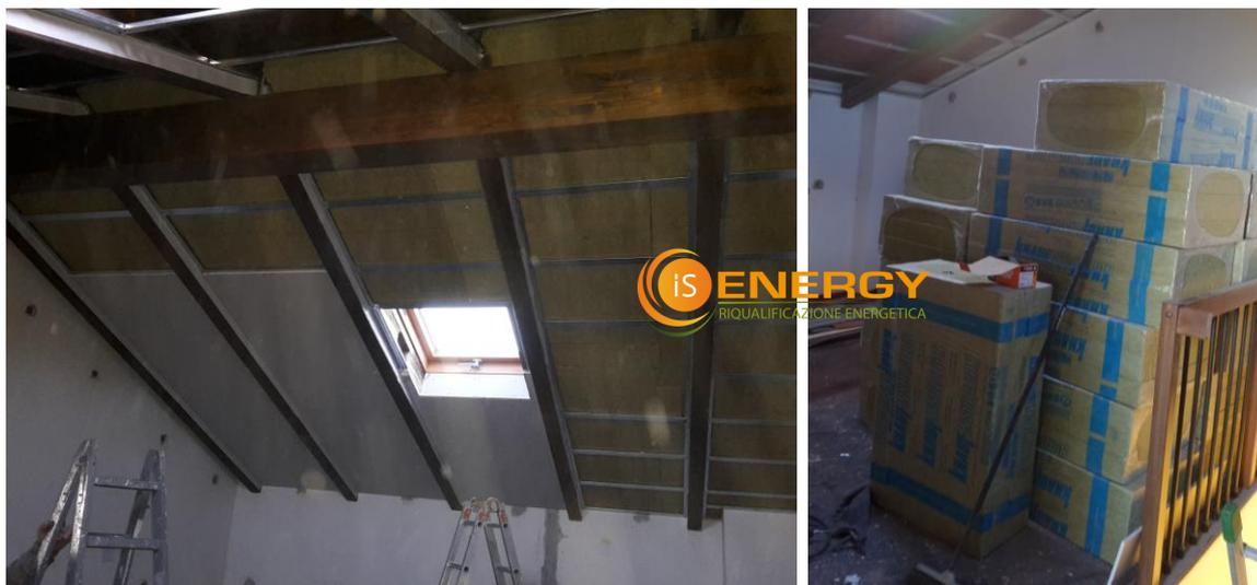
**TETTO:** coibentazione con 10cm di lana di roccia KNAUF 135 kg/m<sup>3</sup> e cartongesso
