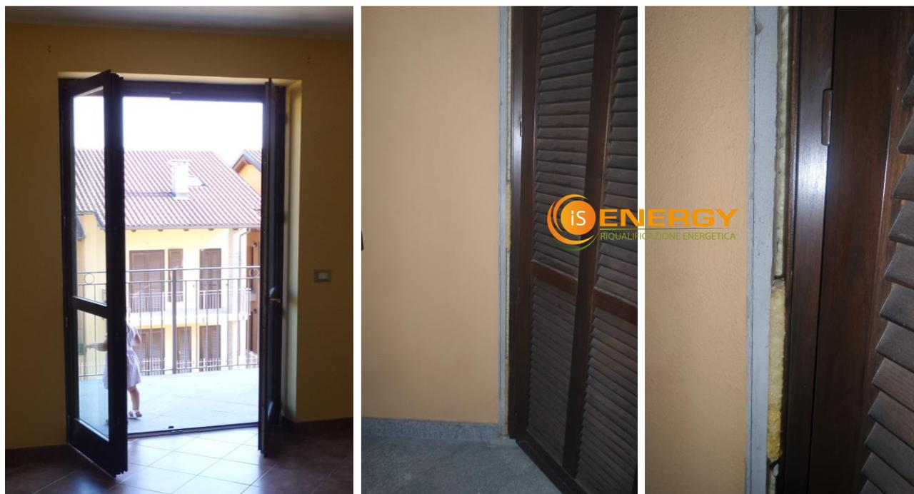
**Infissi in legno:** vetrocamera 4-12-4 con errore di posa (problema di tenuta all'aria, con schiuma poliuretanicca scarsa e mal posata e telaio mal posato con conseguente chiusura non a tenuta).
