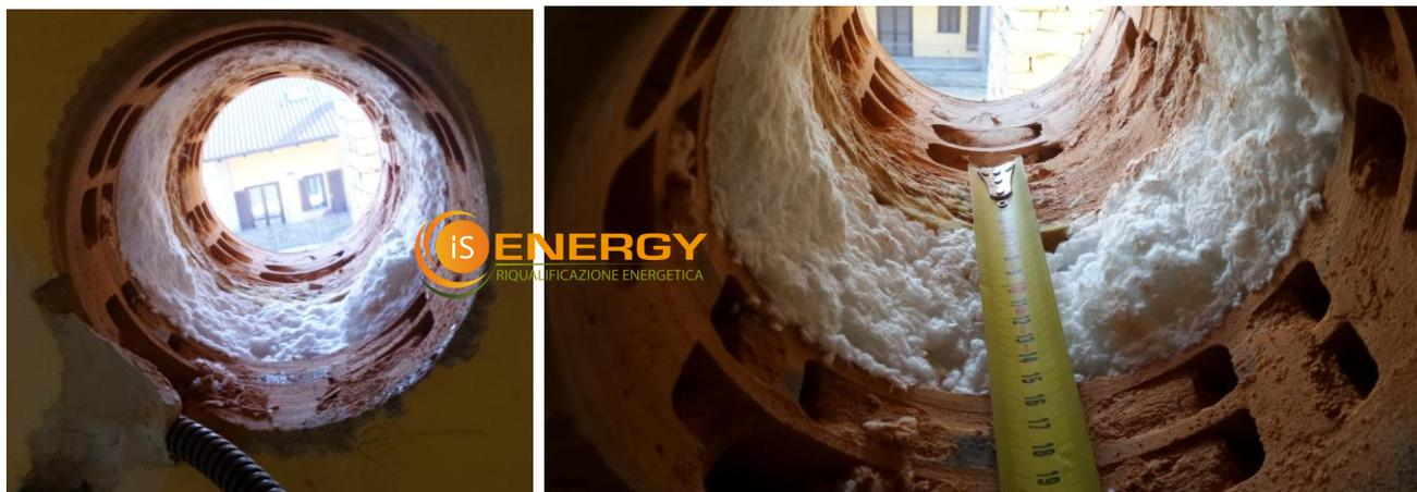
**ISPEZIONE:** foro da 160mm per alloggiamento **LUNOS**, con evidenza del compattamento della lana **KNAUF SUPAFIL** che diventa un vero pannello.
